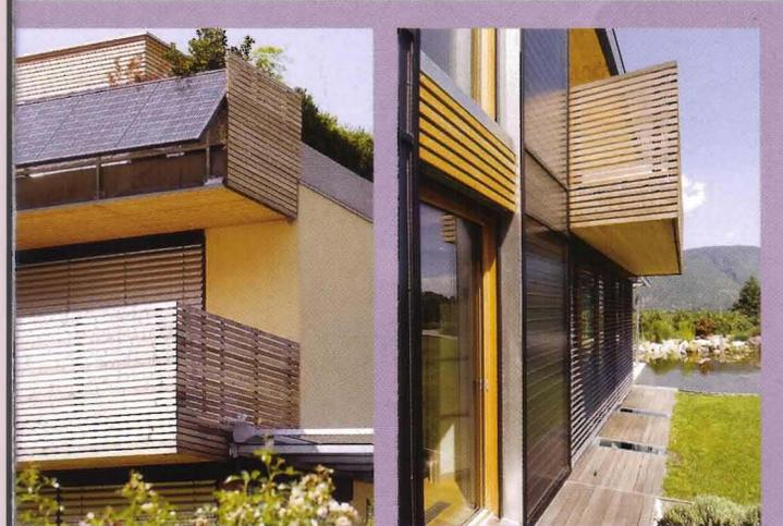
*Un dispositivo automatico consente di inclinare i pannelli fotovoltaici per seguire il movimento del sole, o ritirarli completamente in caso di maltempo*
